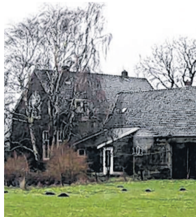
De Annahoeve aan de Voorweg.
